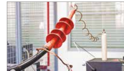
Высоковольтные испытания кабельных муфт
